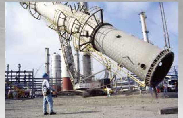
廠房與塔槽安裝
